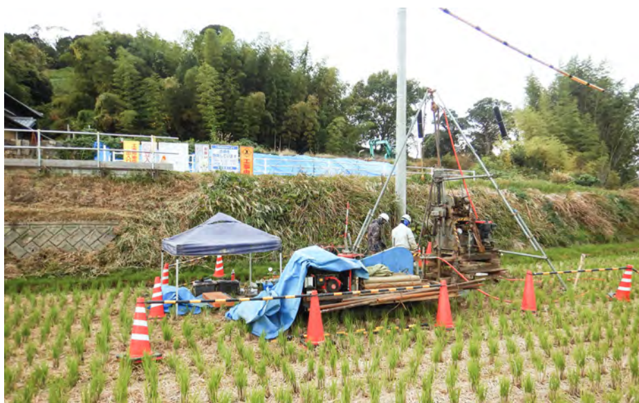
写真1. ボーリングNo.2掘削状況
