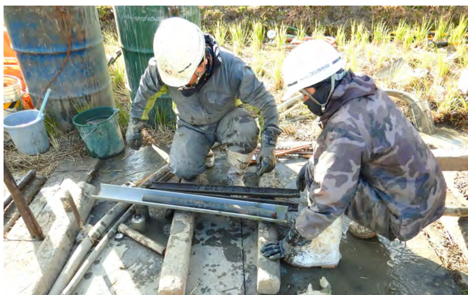
写真2. ボーリングNo.4コア試料採取
