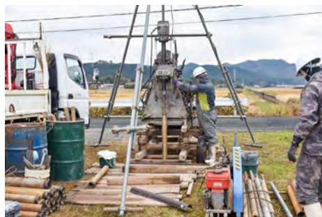
写真1. ボーリング 調査風景
