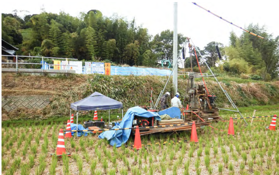
写真1. ボーリングNo.2掘削状況
