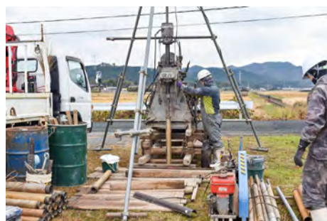
写真1. ボーリング 調査風景
